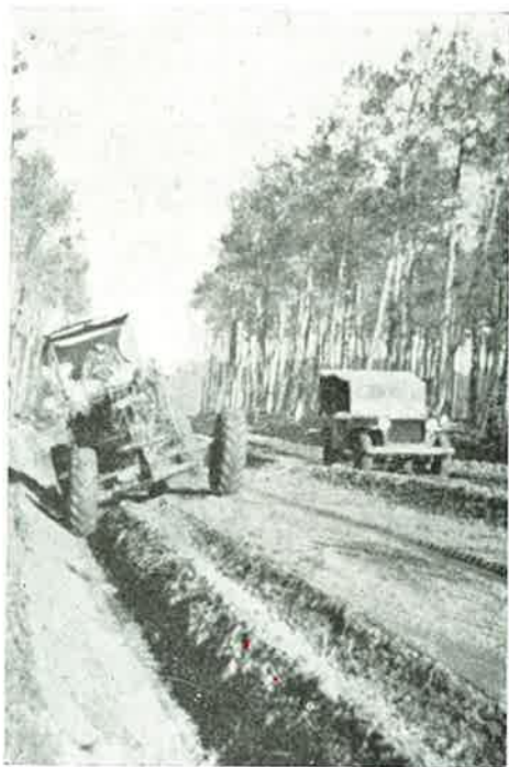
Terminando la apertura de la pista de Louchats con una niveladora automática.
